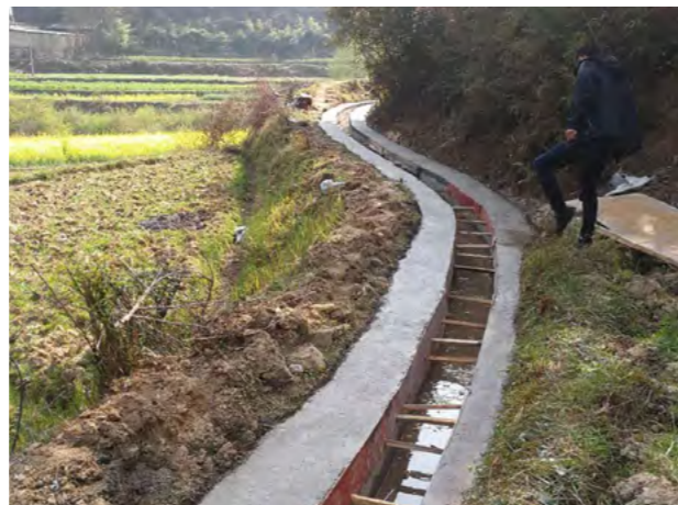
改造中的渠道
