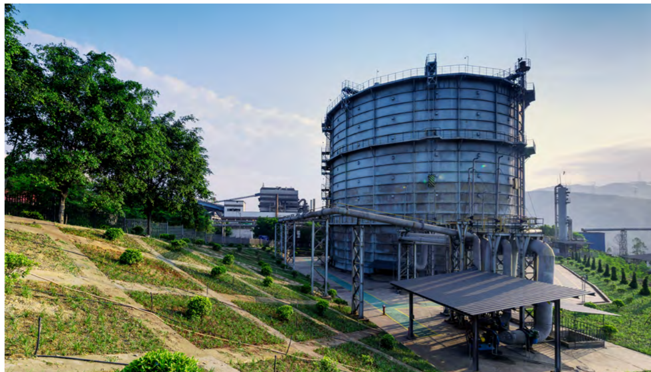
钛冶炼厂煤气回收项目
